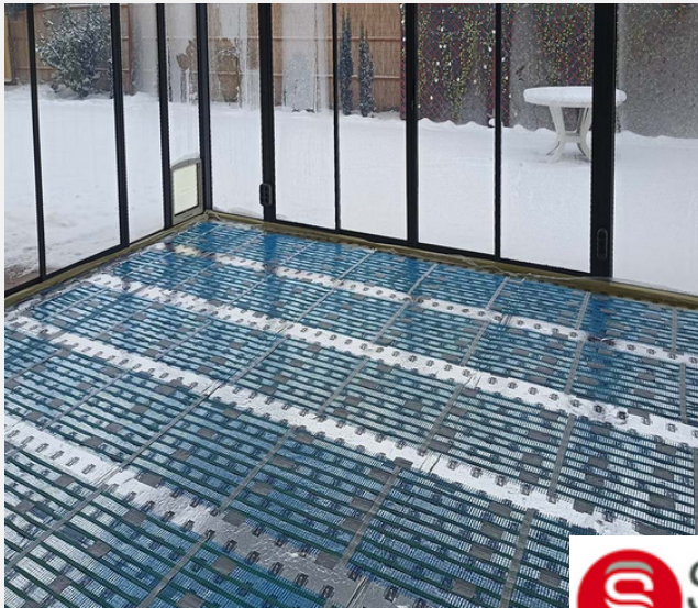
Posa riscaldamento elettrico veranda
