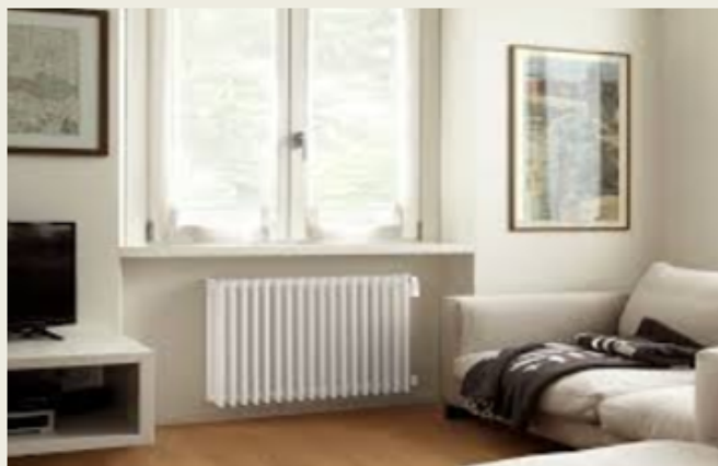
Riscaldamento a termosifoni Idrosanitaria DELTACALORI
